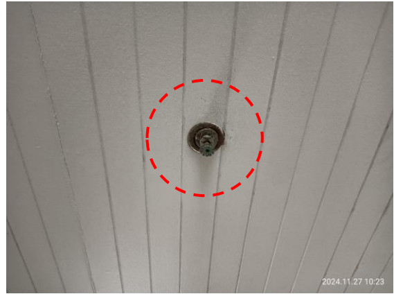
รูปที่ 2.10-8 ระบบสปริงเกอร์ภายในอาคาร
